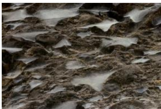
Figure 7 : Toiles en nappe sur un plafond de cave (7)
